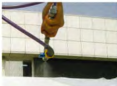
専用塗布機を使用したスプレー方式の施工となります。
